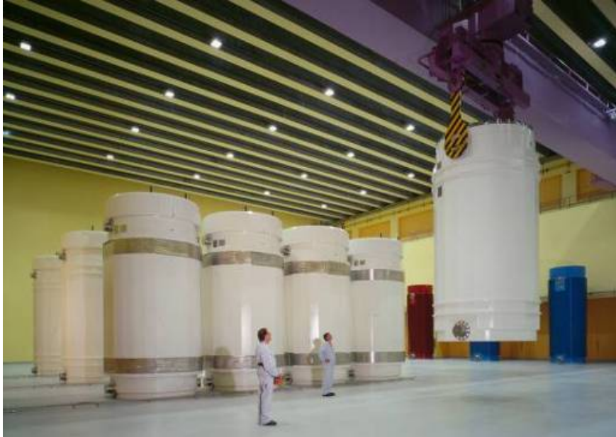
Conteneurs avec assemblages combustibles usés et déchets de haute activité au Centre de stockage intermédiaire de Würenlingen. (Photo: Zwilag)
