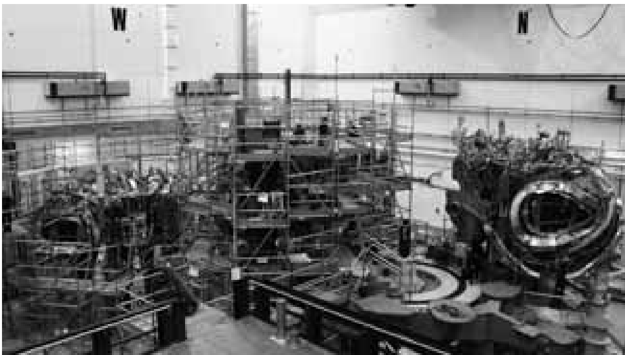
Sämtliche fünf Module der Anlage sind zurzeit in Arbeit.
