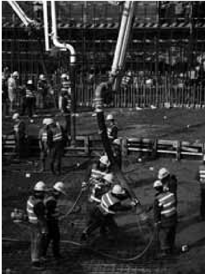
Ende Dezember 2009 wurde der erste Beton für Sanmen-2 gegossen.
