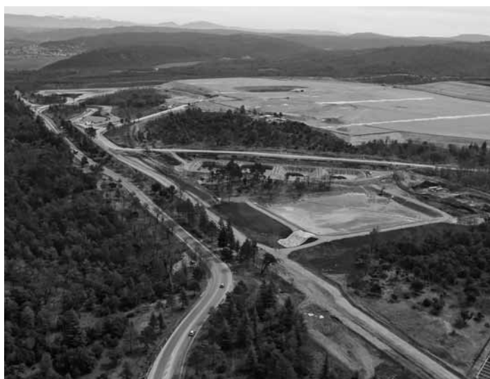
Stand des Iter-Projekts: Bauplatz und Zufahrtsstrassen sind bereit.
