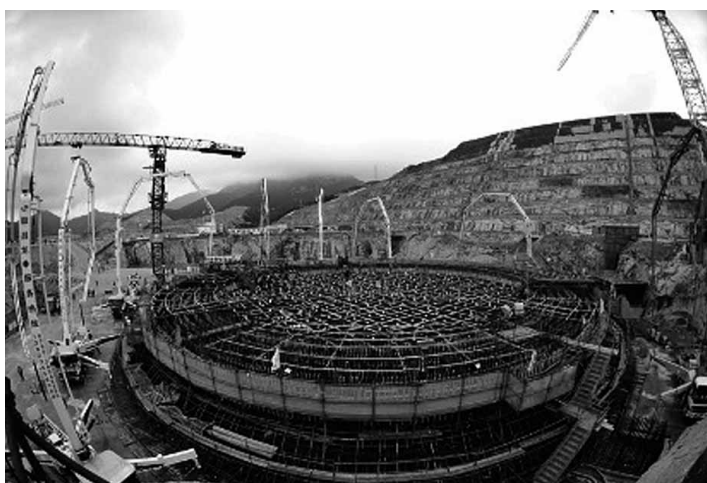
Les travaux de construction de Taishan 2, le deuxième EPR en Chine, ont commencé.
