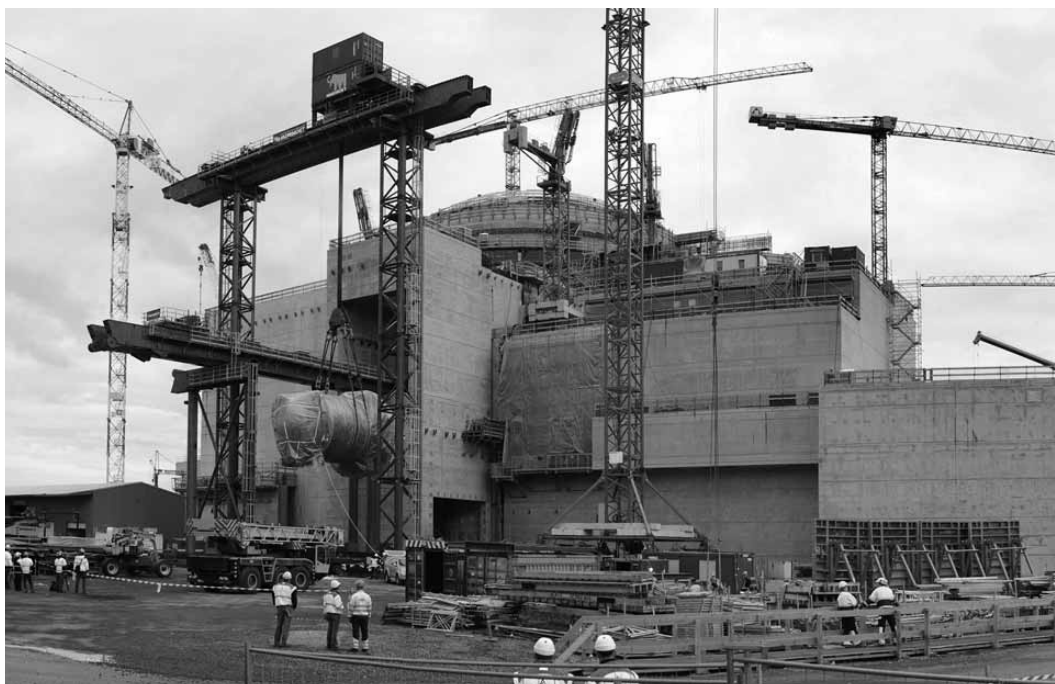
La cuve du réacteur de la tranche finlandaise d'Olkiluoto 3 est introduite dans le bâtiment réacteur.
