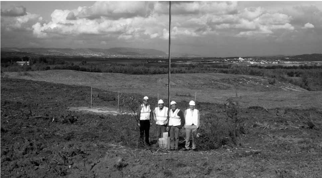
Un piquet surmonté d'un fanion marque le centre de la fosse à excaver pour le tokamak d'Iter.
