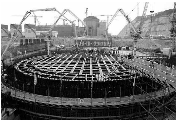
La tranche Yangjiang 3 est officiellement en construction depuis le 15 novembre 2010.
