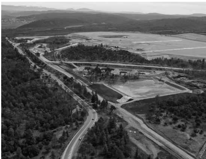
Etat du projet Iter: le chantier et les routes d'accès sont prêts.
