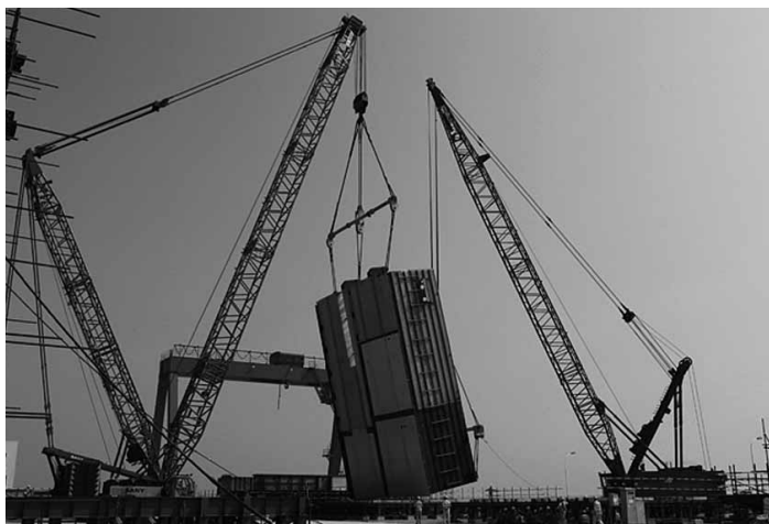
La construction du deuxième AP1000 en Chine, Haiyang-1, progresse comme prévu.
