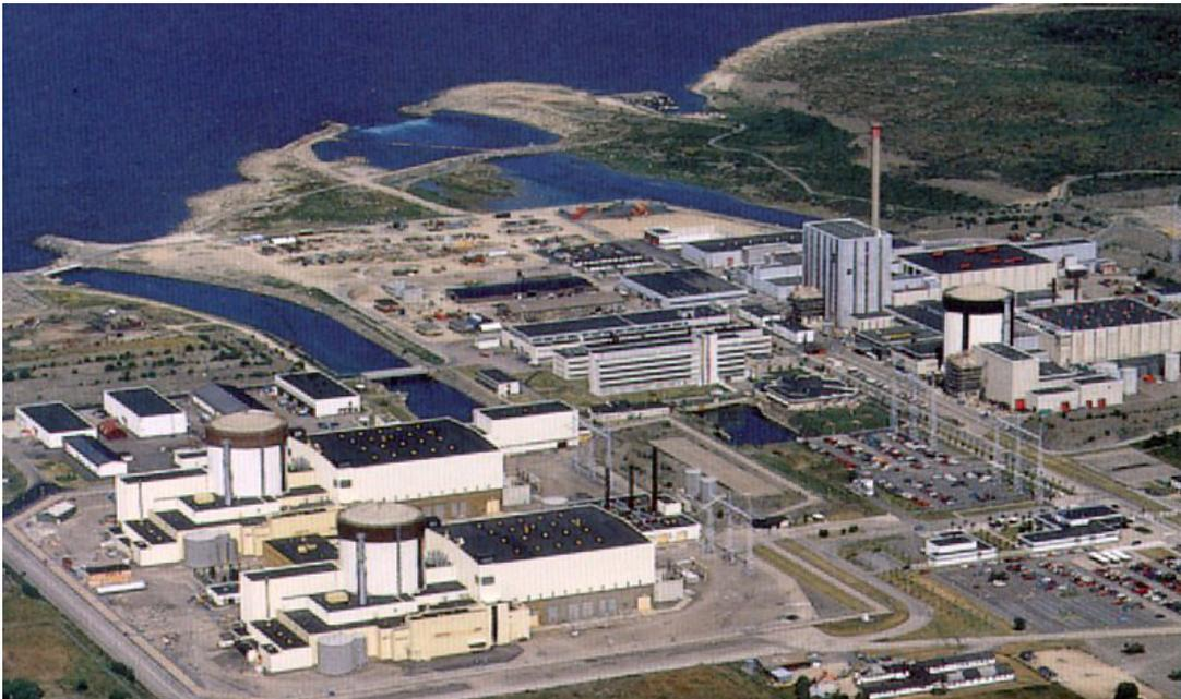
*Das Kernkraftwerk Ringhals an Schwedens Westküste südlich von Göteborg. Die Anlage umfasst einen Siedewasserreaktor (kastenförmiges Reaktorgebäude mit dem Kamin) und drei Druckwasserreaktoren. (Bild: Vattenfall)*
