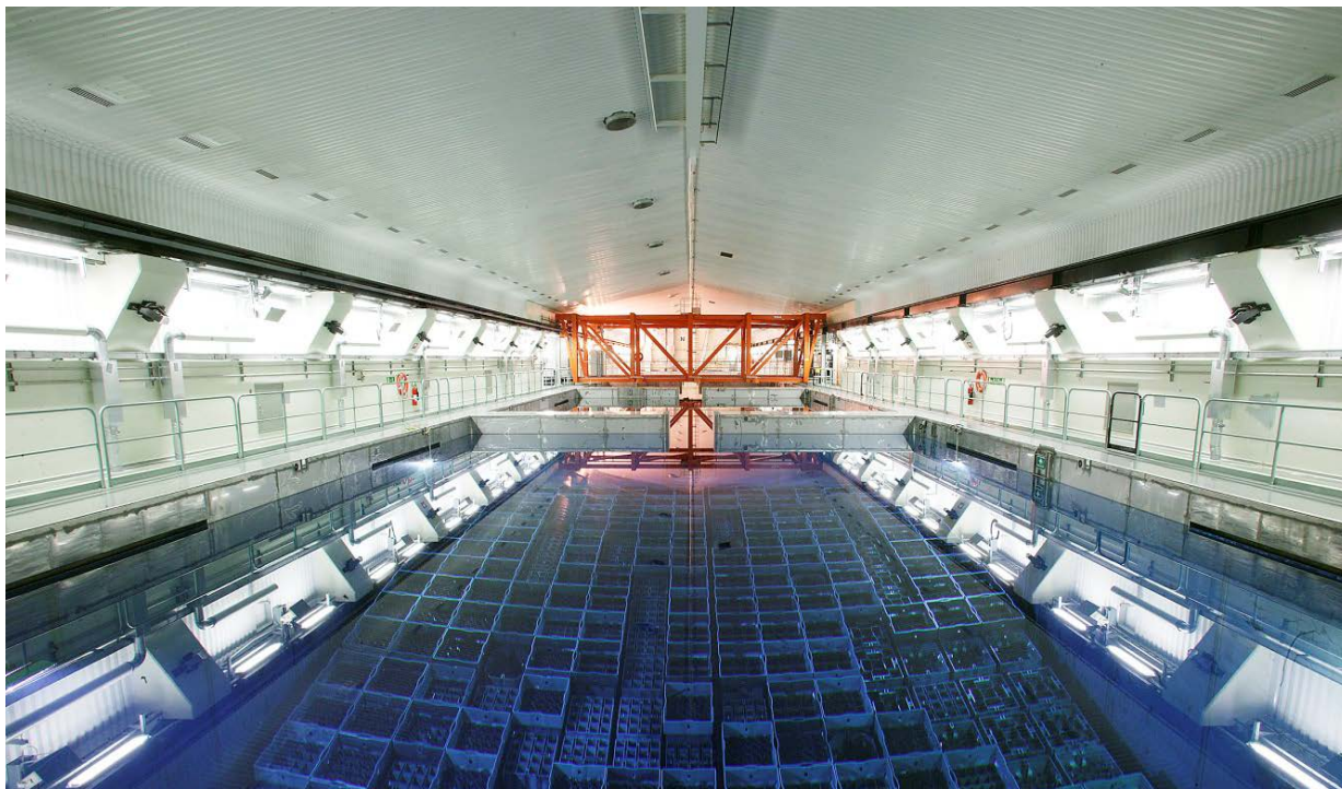
Dépôt en piscine: le dépôt souterrain Clab destiné au stockage intermédiaire, Oskarshamn. (Photo:SKB)
