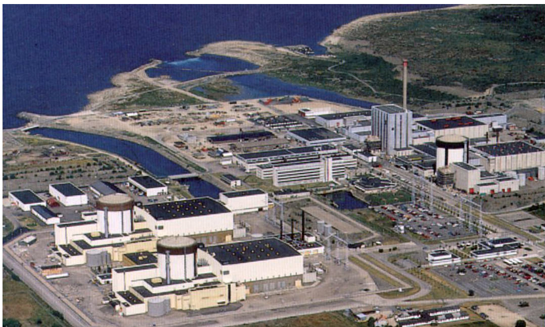
La centrale nucléaire de Ringhals sur la côte occidentale suédoise, au sud de Göteborg. La centrale comprend un réacteur à eau bouillante (bâtiment réacteur en forme de caisson avec la cheminée) et trois réacteurs à eau sous pression. (Photo: Vattenfall)
