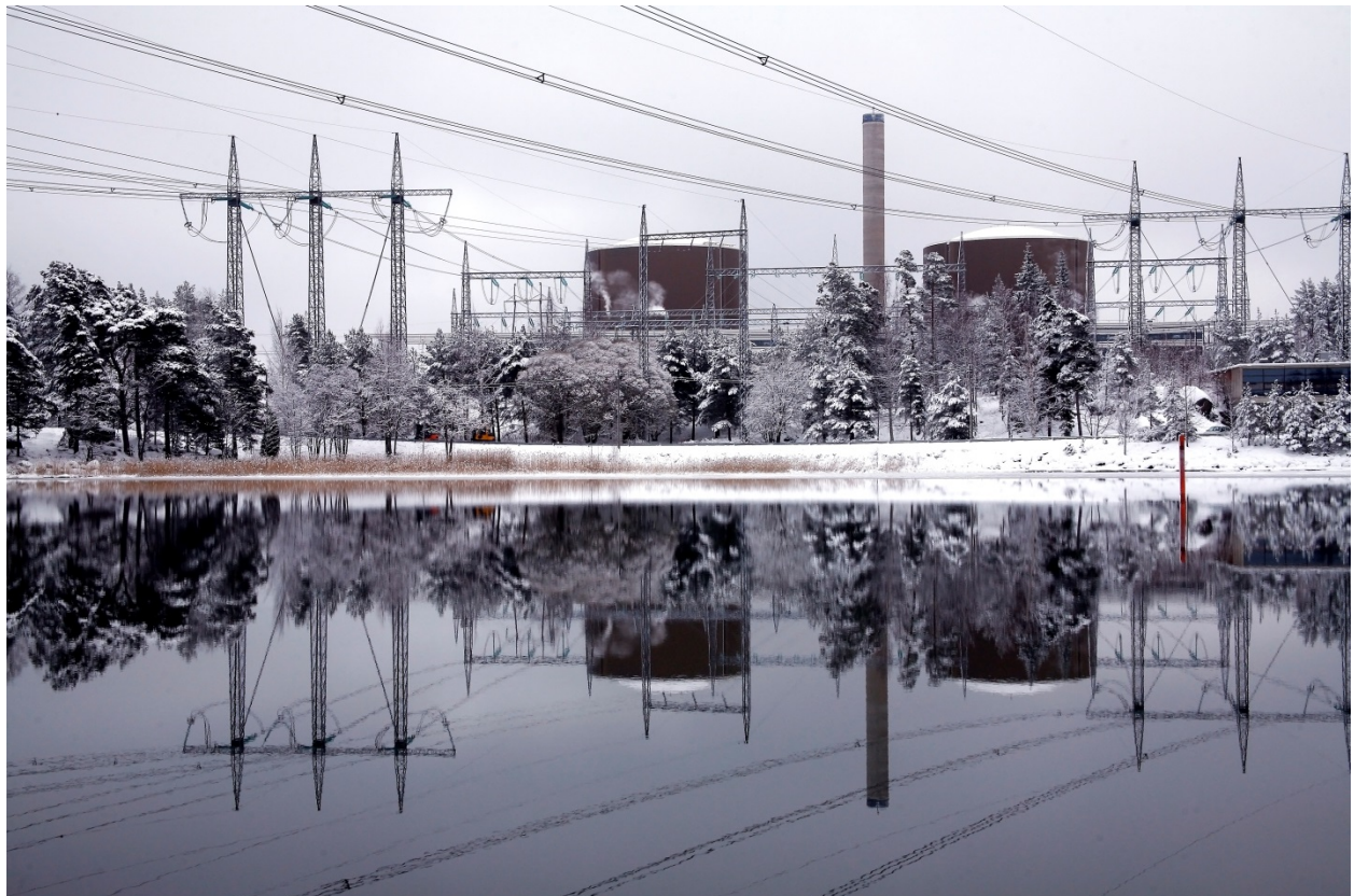
Kernkraftwerk Loviisa (Bild:Fortum)
