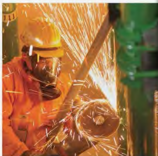
Démontage par étapes: travaux de démantèlement dans une centrale nucléaire allemande de 1300 MW. Photo: KKW Mülheim-Kärlich
