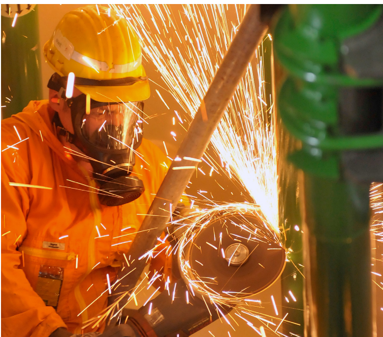
Demontage Schritt um Schritt: Rückbau in einem deutschen Kernkraftwerk der 1300-Megawatt-Klasse.
