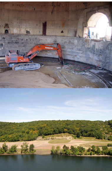
Rückbau des 590-Megawatt-Kernkraftwerks Connecticut Yankee (USA): vom Abbau des Reaktorgebäudes (oben) bis zur grünen Wiese (unten).
