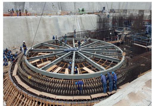
Baustelle des Carem-25 in Atucha, Argentinien. Der kleine Druckwasserreaktor dient als Prototyp für die weitere Entwicklung kleiner, modularer Reaktoren.
