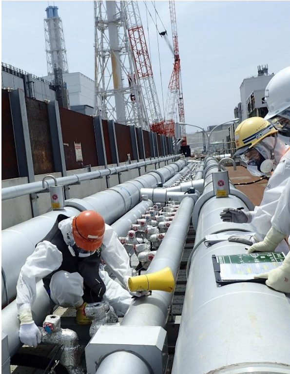
Des risques sanitaires minime pour le personnel: les techniciens lors de travaux sur l'installation de réfrigération pour le mur de glace. (Juin 2016, Photo: Tepco)
