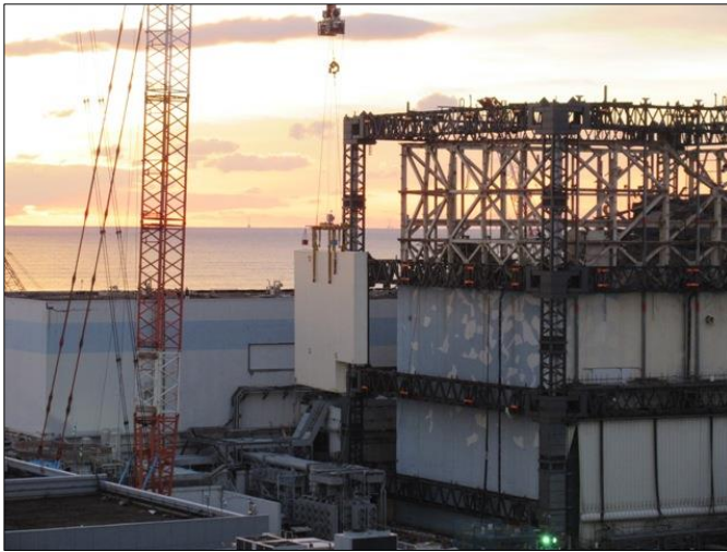
Condition à l'enlèvement des débris: l'enveloppe de protection de la tranche 1 a été à nouveau retirée en novembre 2016. (Photo: Tepco)
