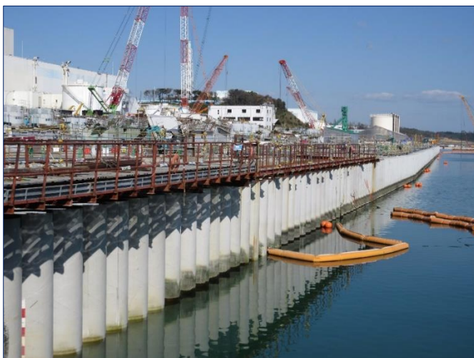
Mur de protection en acier destiné à empêcher l'écoulement de l'eau contaminée dans la mer. (Photo: Tepco)
