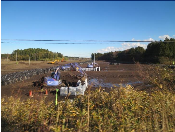
Travaux de décontamination: retrait de la couche supérieure du sol (Photo: Tepco)
