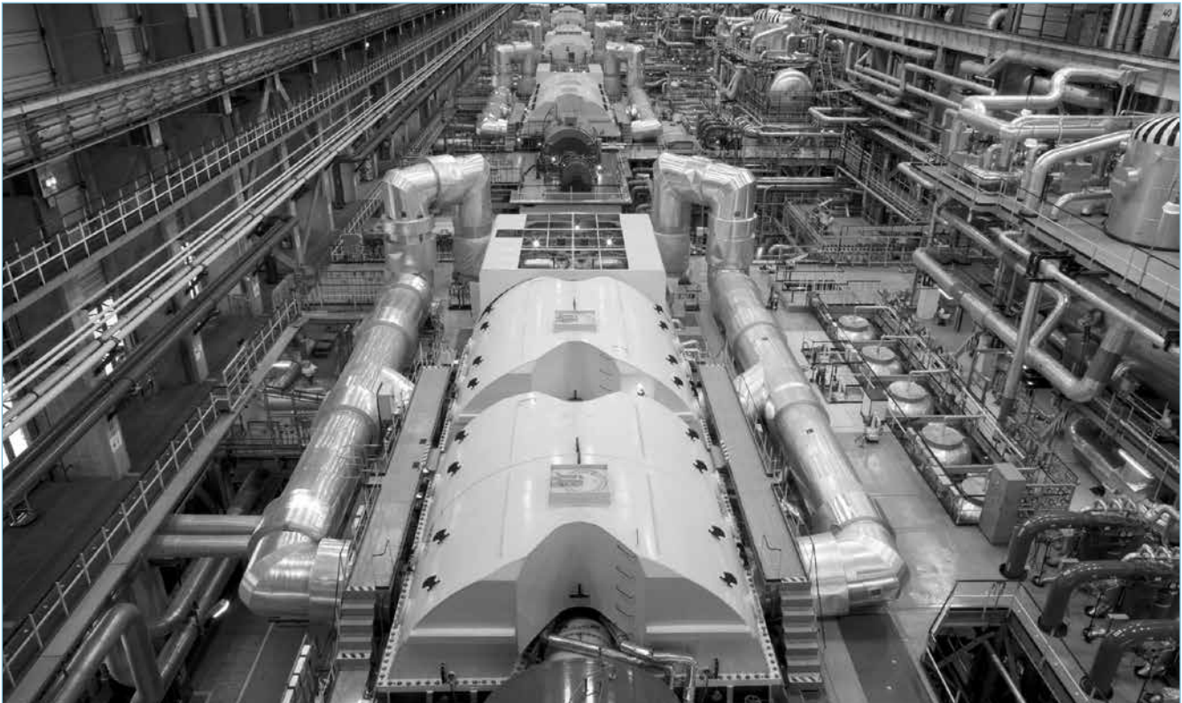
Kernkraftwerks Paks: Blick in die Turbinenhalle mit einer Länge von rund 500 m, in der acht Turbinen-Generator-Gruppen untergebracht sind.
