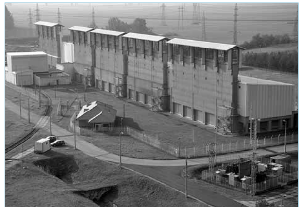
Das modular aufgebaute Trockenzwischenlager für bestrahlte Brennelemente am Standort Paks.
