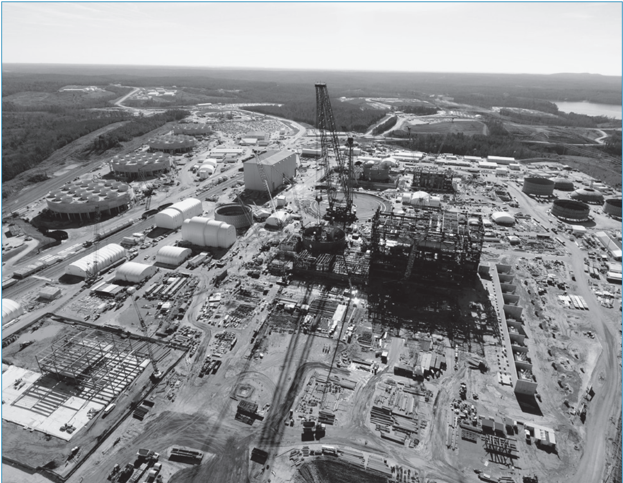
Die Baustelle V. C. Summer im amerikanischen Bundesstaat South Carolina im Januar 2017
