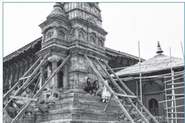
Zerstörungsfreie Materialprüfung zur Katastrophenbewältigung: Nach dem schweren Erdbeben in Nepal wurden Gebäude und Tempel auf versteckte Risse überprüft.
