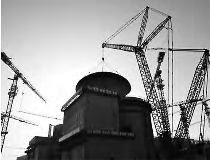
Mit der Platzierung der Reaktorkuppel (Durchmesser 37 m, Höhe 11 m) der vierten Einheit hat das Ningde-Bauprojekt einen weiteren Meilenstein erreicht.
