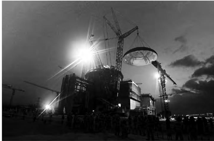
Die Reaktorkuppel von Fuqing-3 wird frühmorgens auf das Reaktorgebäude aufgesetzt.
