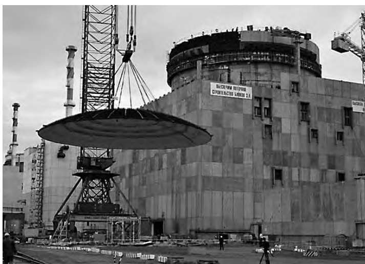
Le 29 octobre 2012, le dôme de l'enceinte métallique de Rostov 3 a été posé sur le bâtiment du réacteur.
