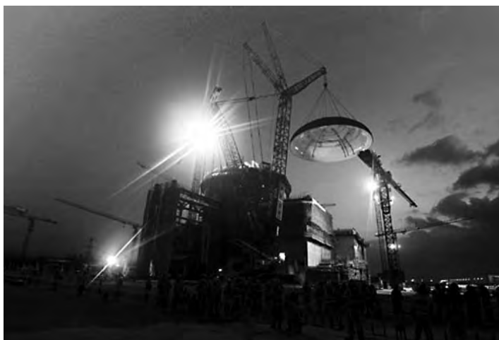
Pose du dôme du réacteur de Fuqing 3, tôt le matin.
