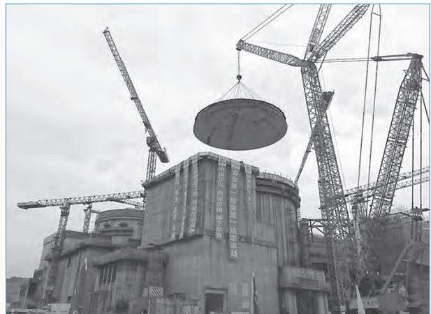
Die **Containmentkuppel** für die sechste Einheit des Kernkraftwerks Yangjiang wird platziert.
