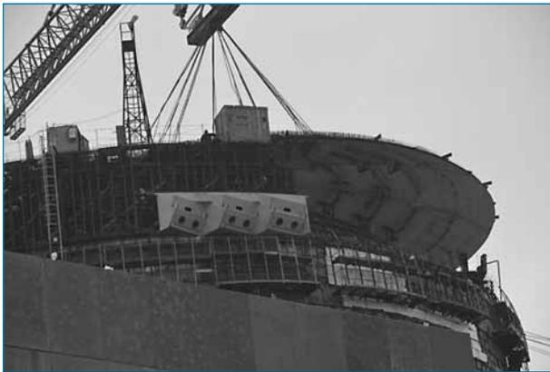
Die Kuppel des Metallcontainments von Rostow-4 wird millimetergenau positioniert.
