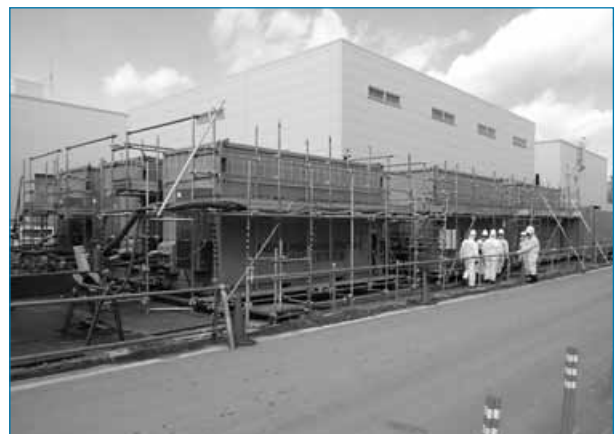
Anlage zur Wasseraufbereitung im Kernkraftwerk Fukushima-Daiichi.
