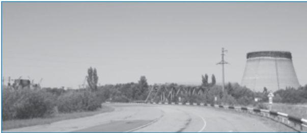
Reaktorblock 5 (links) sowie einer der beiden halbfertigen Kühltürme.
