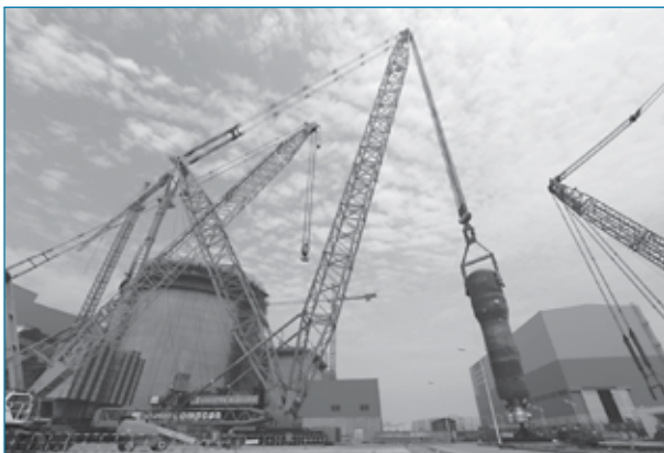
Der zweite Dampferzeuger der AP1000-Einheit Sanmen-2 in China wird ins noch offene Reaktorgebäude gesetzt.
