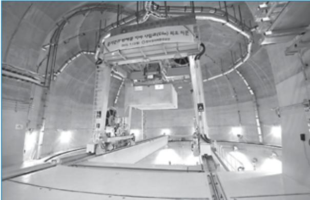
**Mise en service du premier dépôt en couches géologiques profondes d'Asie: le premier conteneur de béton composé de 16 fûts a été placé dans un des six silos.**
