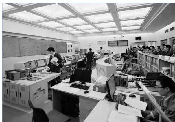
Der Kontrollraum der Einheit Ningde-1 während der ersten Stromabgabe.
