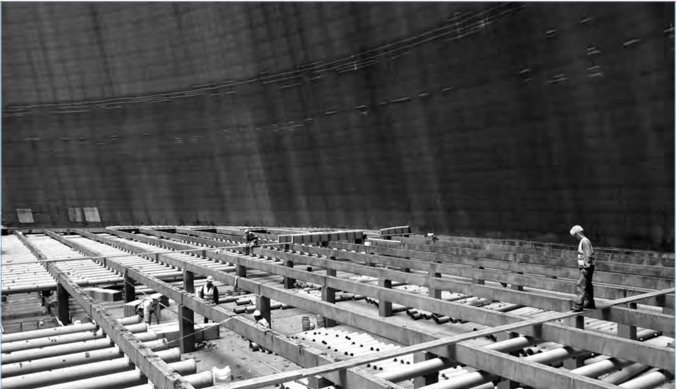
Einbau der neuen Verteilrohre im Turminnern, in rund 12 m Höhe.
