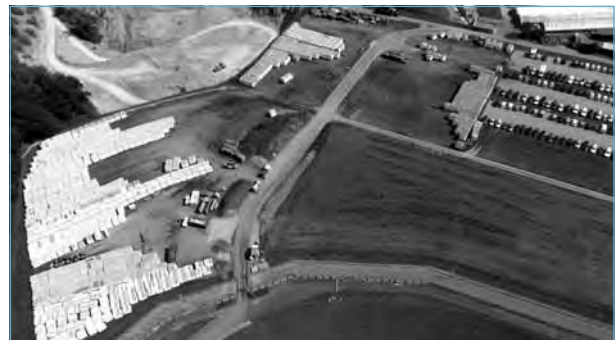
Blick von der Spitze des Kühlturms auf die neuen Rieselpakete im Aussenlager mit separater Zufahrtsstrasse. Im Vordergrund die neuen Wasserverteilerohre.
