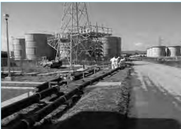
**Umweltmanagement: Das zufließende Grundwasser wird über einen Bypass um die Anlage herumgeleitet.**
