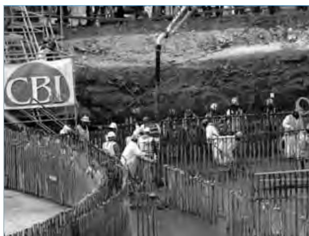
La construction de Virgil C. Summer 2 en Caroline du Sud a officiellement débuté le 11 mars 2013.
