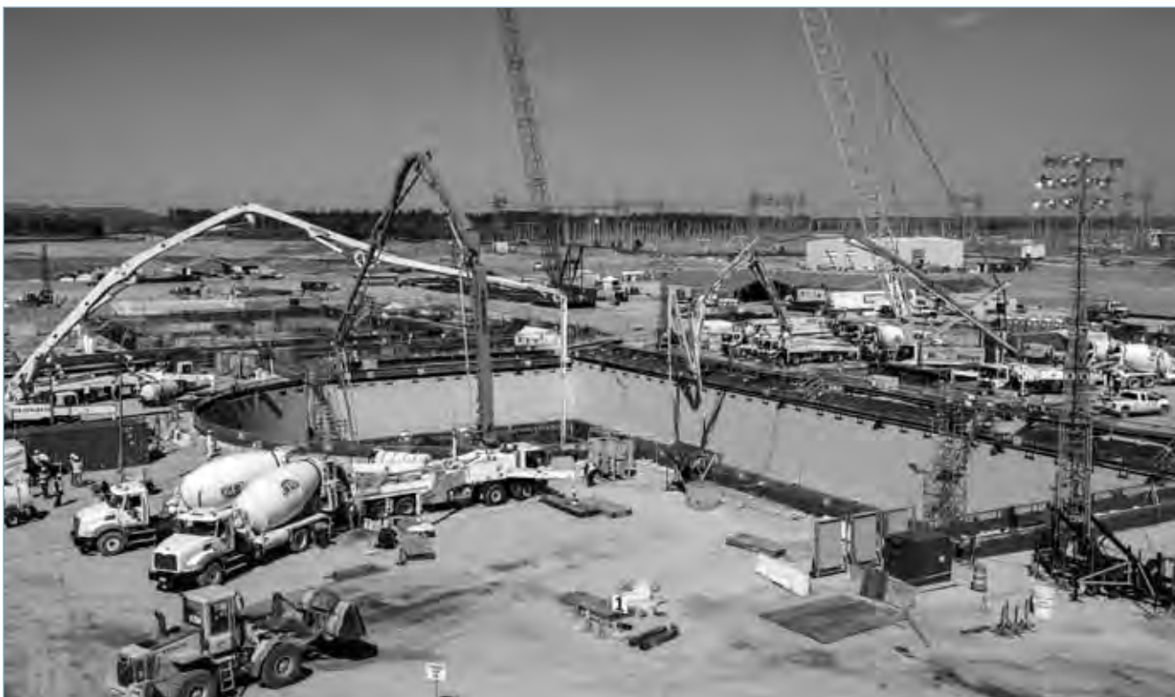
Le coulage du premier béton de Vogtle 3, en Géorgie, s'est achevé avec succès le 14 mars 2013.
