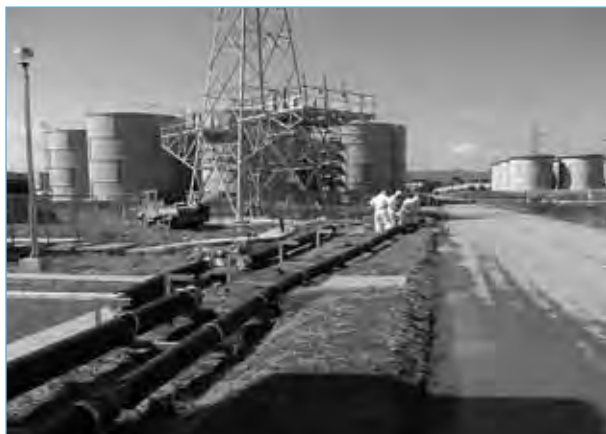
Gestion environnementale: les eaux souterraines sont déviées et contournent l'installation.
