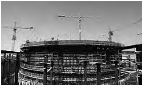
Barakah 1: le montage de l'enceinte de sécurité du bâtiment réacteur a commencé.
