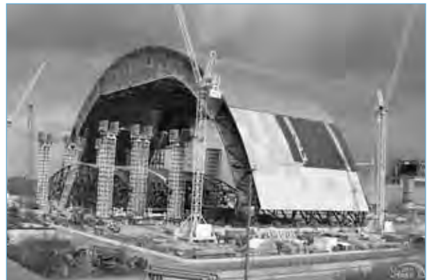
Die östliche Teilkonstruktion der neuen Sicherheitshülle für Tschernobyl-4 ist fertiggestellt.
