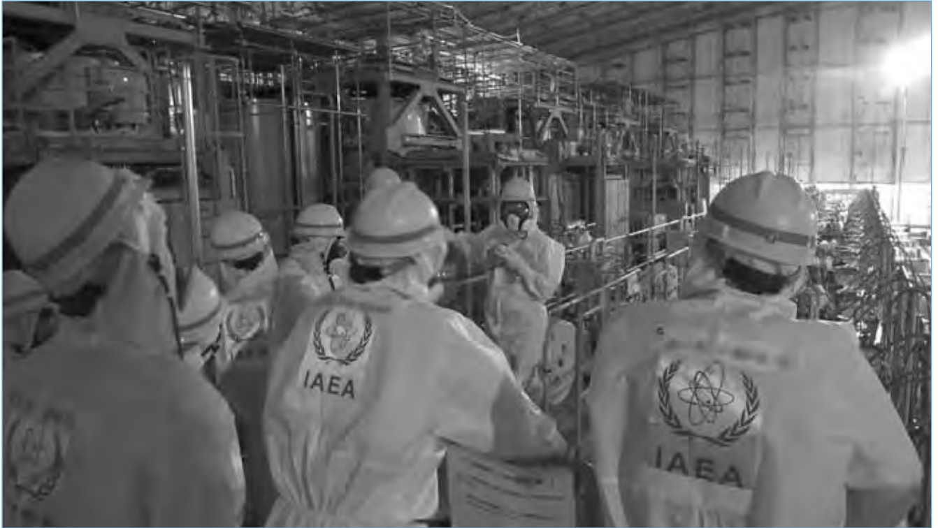
Ausblick: Besuch der Fachleute der IAEA in der neuen Wasser- aufbereitungsanlage «Advanced Liquid Processing System» (ALPS), das ab April 2014 vollständig operationell sein soll.
