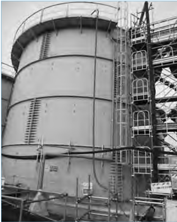
In solchen Tanks wird das gefilterte Wasser auf dem Kraftwerksgelände gelagert.
