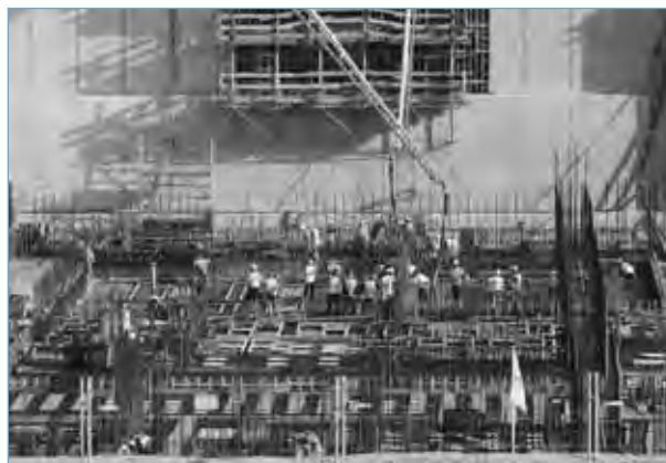
Im Nordosten der Tokamakgrube wird der erste Beton für das Fundament des Tritiumgebäudes des Fusionskraftwerks Iter gegossen.
