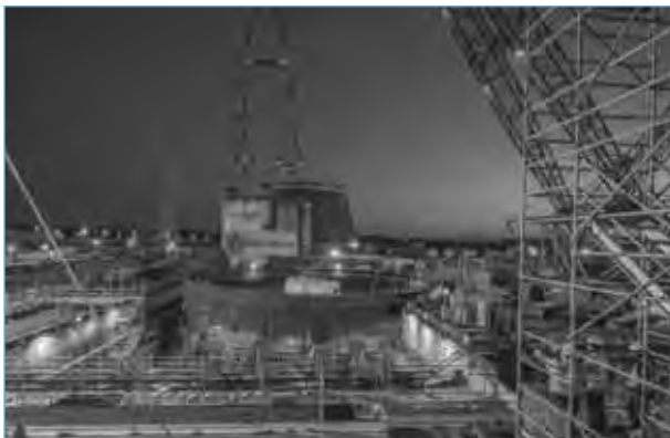
Sichtbare Fortschritte auf der Baustelle von Vogtle-3: Das Auxiliary Building Module CA-20 wird platziert.
