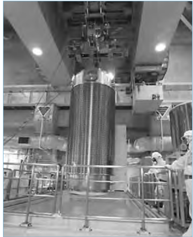
Abtransport des unbeschädigten Kernbrennstoffs aus dem Lagerbecken des Blocks 4.
