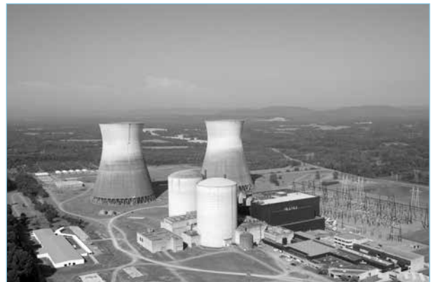
Der Kernkraftwerksstandort Bellefonte im Bundesstaat Alabama soll an den Meistbietenden veräussert werden. Der Mindestpreis legte ein unabhängiges Gutachten auf USD 36,4 Mio. (CHF 35,5 Mio.) fest.
