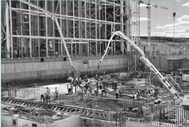
Selon l'organisation Iter, environ 540 m<sup>3</sup> de béton ont été nécessaires pour remplir l'aire de 750 m<sup>2</sup> située dans le coin sud-est de la fosse du tokamak.
