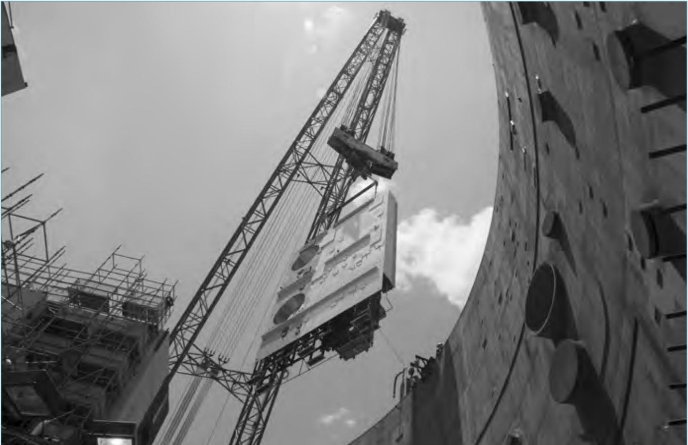
**Nouvelles avancées sur le chantier de la tranche Vogtle 4: le module du bâtiment des auxiliaires nucléaires CA-20 a été mis en place le 20 août 2016.**
