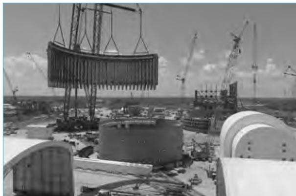
Le module CA-03 est levé au-dessus de son emplacement de montage et placé dans le bâtiment réacteur de la tranche AP1000 Virgil C. Summer 2.
