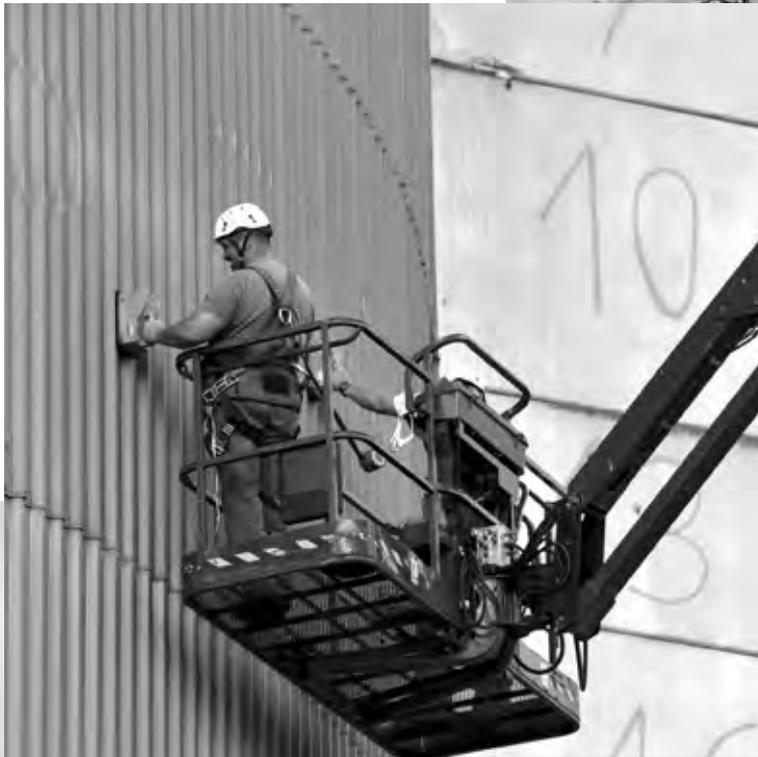
**◀ Mesures de radioprotection sur l'enveloppe externe du bâtiment réacteur.**
