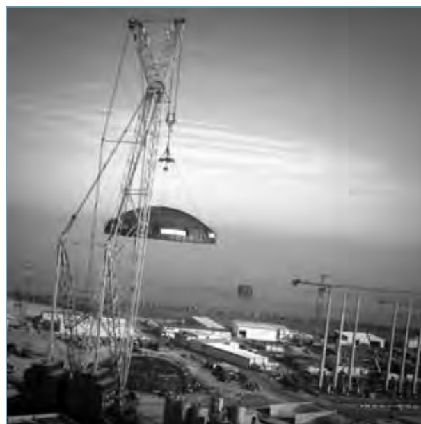
D'un poids de 260 tonnes, le dôme du bâtiment réacteur de l'EPR Flamanville 3 a été posé avec succès.
