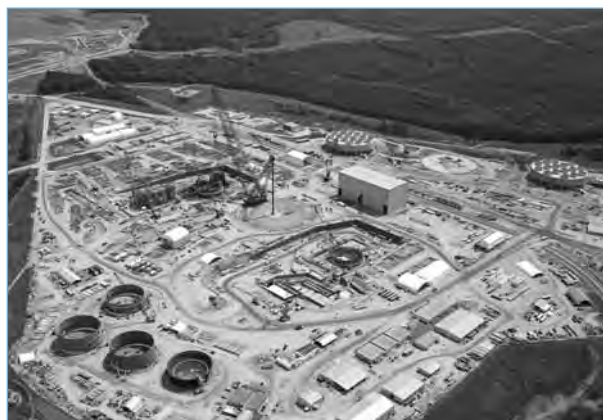
Luftaufnahme der Baustelle am Standort Jenkinsville im Bundesstaat South Carolina, wo seit 2013 die zwei AP1000-Einheiten Virgil C. Summer-2 und -3 in Bau sind.
