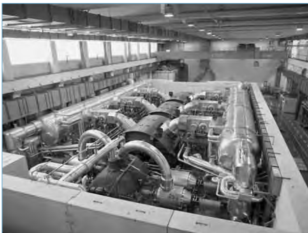
Das Kernkraftwerk Leibstadt erhält auf die Jahreshauptrevision 2017 neue Wasserabscheider-Zwischenüberhitzer.
