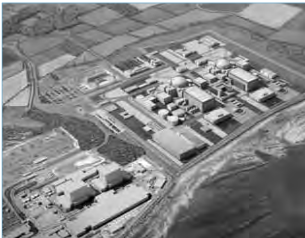
Die Vereinbarung zwischen der britischen Regierung und der französischen EDF ebnet den Weg zum Bau des ersten Kernkraftwerks in Grossbritannien seit 1995 (Fotomontage von Hinkley Point C),
