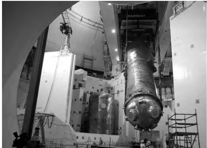
Anfang Dezember 2010 wurde der dritte Dampferzeuger ins Reaktorgebäude von Olkiluoto-3 eingebaut.
