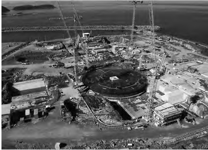
Die Finanzierung des Weiterbaus der Kernkraftwerkseinheit Angra-3 in der Bucht von Angra dos Reis, westlich von Rio de Janeiro, ist gesichert.
