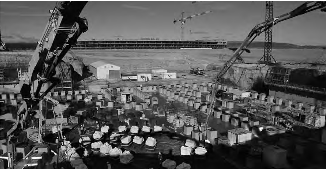
Im Dezember 2011 wurde das Fundament für das Tokamak-Gebäude fertiggestellt.
