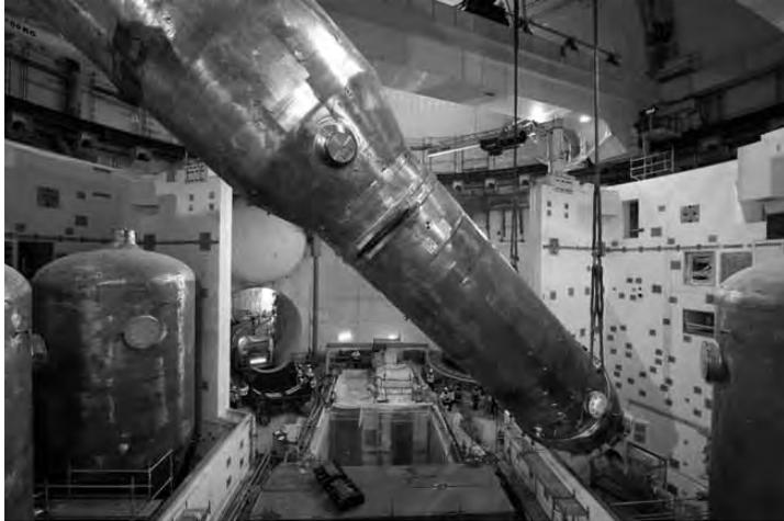
Der vierte und letzte Dampferzeuger wird im Reaktor-gebäude von Olkiluoto-3 – dem weltweit ersten EPR – installiert.
