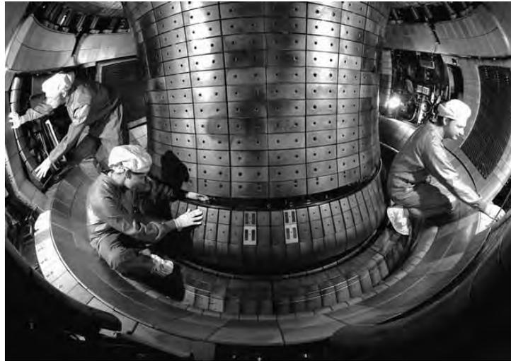
Spezialisten bauen Regelspulen in das Plasmagefäss der Fusionsanlage Asdex Upgrade ein.
