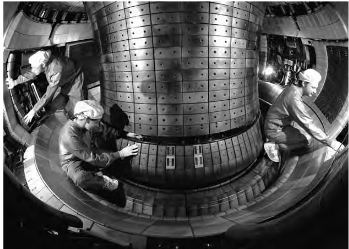
Des spécialistes installent des bobines de régulation dans la chambre à plasma de l'installation de fusion Asdex Upgrade.
