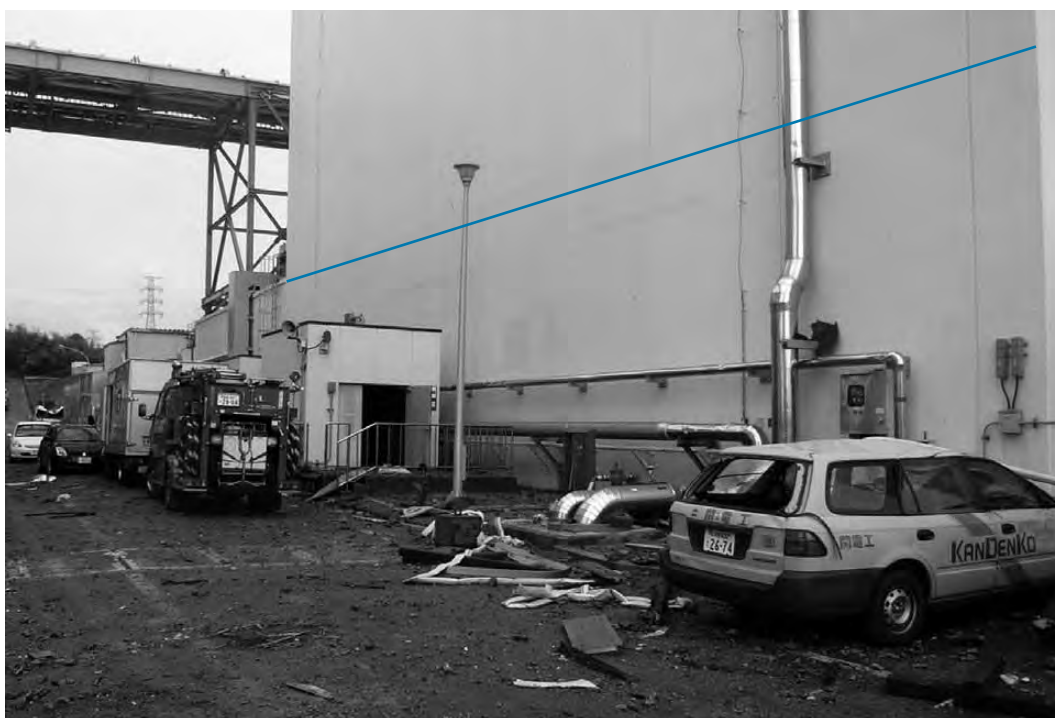
Reaktorgebäude von Block 3: die blaue Linie an der Wand zeigt die Höhe der Überflutung.
