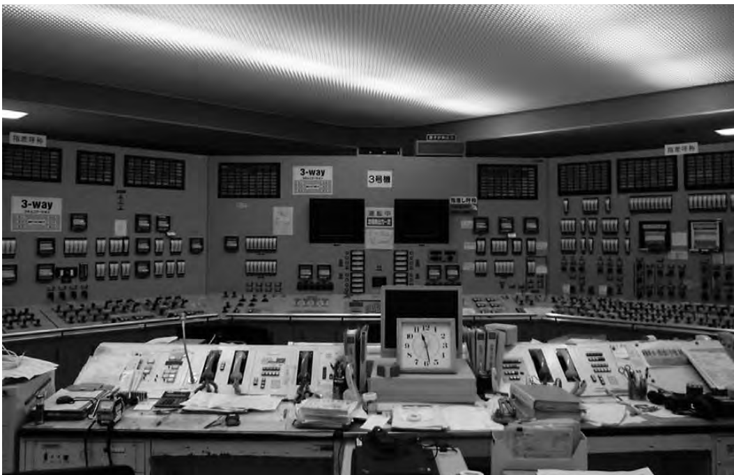
Der weitgehend unbeschädigte Kontrollraum von Block 3 am 22. März 2011.
