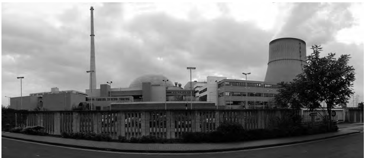
Die drei jüngsten Kernkraftwerkseinheiten Deutschlands – darunter Emsland – dürfen bis Ende 2022 am Netz bleiben.
