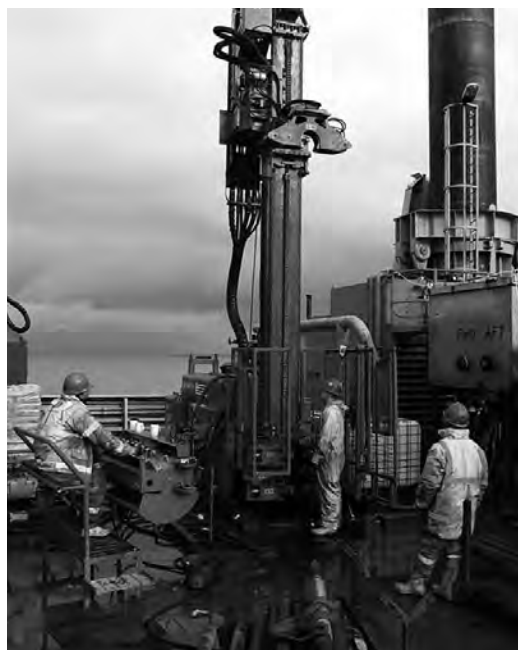
Vorbereitende Arbeiten für Hinkley Point C.
