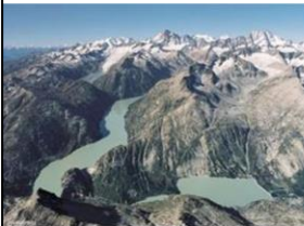
Kraftwerksanlagen auf der Grimsele
