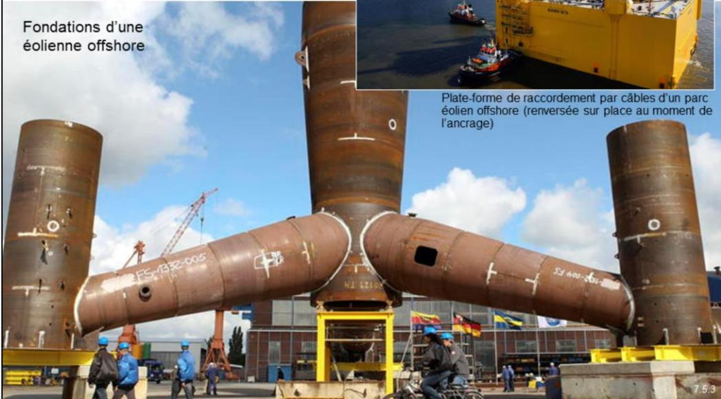
Plate-forme de raccordement par câbles d'un parc éolien offshore (renversée sur place au moment de l'ancrage)
