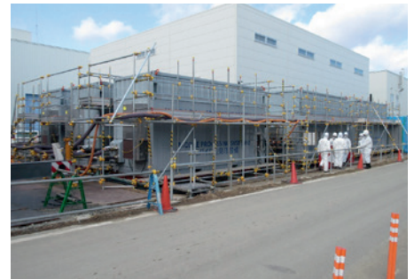
Anlage zur Wasseraufbereitung im Kernkraftwerk Fukushima-Daiichi.
