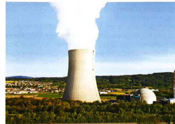
Das Kernkraftwerk Gösgen deckt etwa 15 Prozent des schweizerischen Stromverbrauchs ab.
