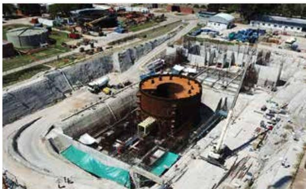
Der Carem (Central Argentina de Elementos Modulares) geht auf eine aufgegebene Entwicklung eines U-Boot-Antriebssystems zurück. Es handelt sich um einen Druckwasserreaktor, bei dem die Dampferzeuger in den Reaktordruckbehälter integriert sind. Das System verfügt über passive Sicherheit. Der Prototyp Carem-25 steht derzeit neben dem Kernkraftwerk Atucha in Bau. Entwicklungsziel sind leistungsstärkere Versionen bis 120 MW<sub>e</sub>.
