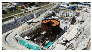
Carem (Central Argentina de Elementos Modulares) reprend le développement d'un système de propulsion sous-marin abandonné entre-temps. Il s'agit d'un réacteur à eau sous pression dans lequel les générateurs de vapeur sont intégrés dans la cuve de pression enterrée. Il possède une sécurité passive. Le prototype Carem-25 est actuellement en construction à côté de la centrale nucléaire d'Atucha. L'objectif est ensuite de construire des versions plus puissantes pouvant atteindre 120 MW<sub>e</sub>.
