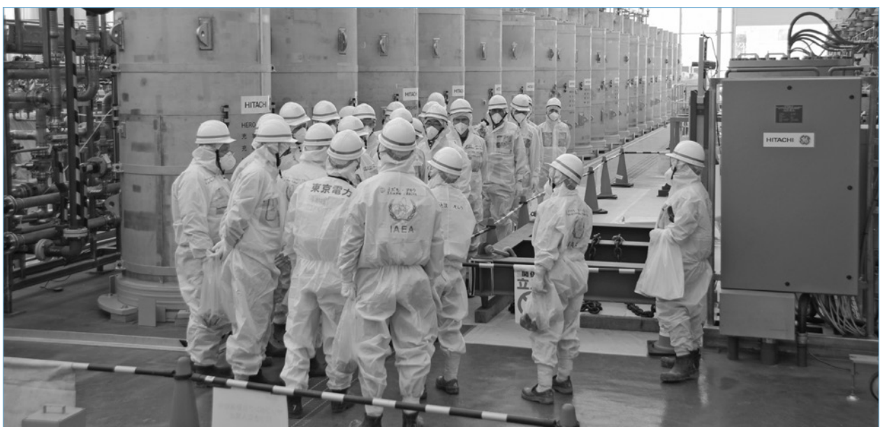
Experten der dritten IEAO-Mission überprüfen im Februar 2015 ein Wasseraufbereitungssystem auf dem Gelände von Fukushima-Daiichi, das radioaktive Elemente aus dem Wasser entfernen kann.
