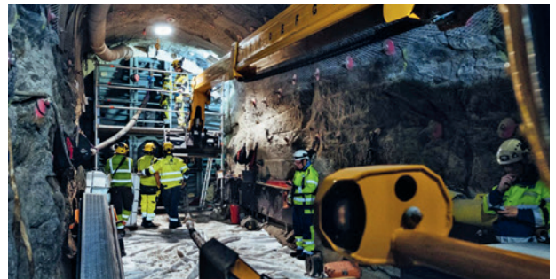
Une galerie du dépôt profond finlandais d'Onkalo. À compter de 2025, des assemblages combustibles usés seront stockés de manière durable et sûre à 400 mètres de profondeur. (Photo: Posiva)
