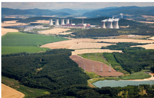
Prise de vue aérienne de la centrale nucléaire slovaque de Mochovce. (Photo: Slovenské elektrárne)
