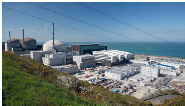
Le premier chargement en combustible de la tranche Flamanville 3 a été repoussé au 2 e trimestre 2023. (Photo: EDF / Alexis Morin)
